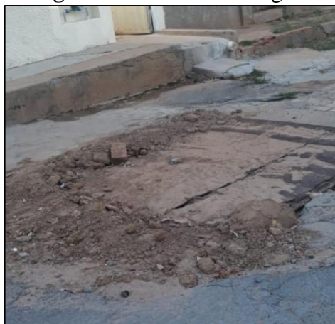
Figura 5 - Ponto de drenagem
