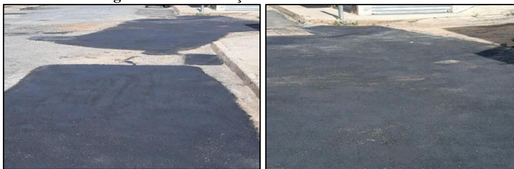
Figura 14 e 15 – Lançamento do material asfáltico
