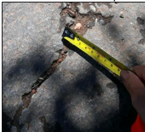
Figura 10 - Trinca com 2cm antes do período de chuva
