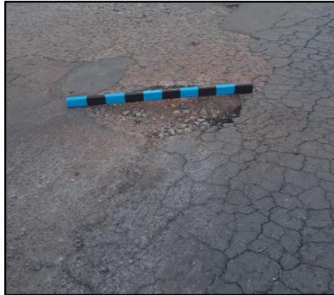
Figura 6 - Panela com 80 cm de largura
